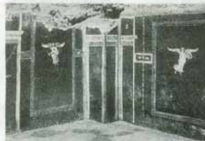
Angeli La Grande Sala decorata dell'edificio crollato
