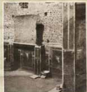
L'interno durante gli scavi di inizio '900
