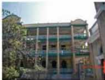
Façade côté parvis de l'église Plusieurs nœuds de structure nécessitent des reprises. photo 06.02.2010
