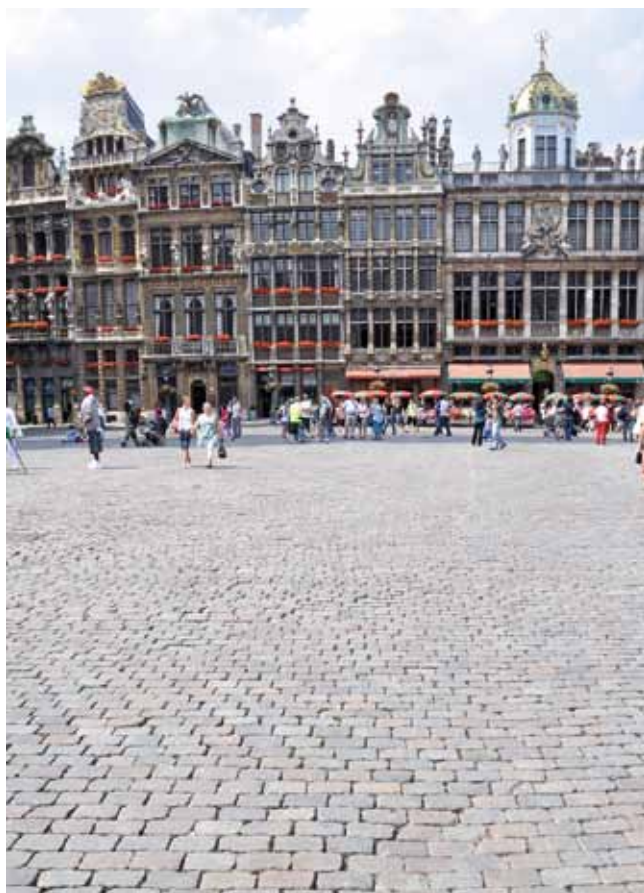
Pavés en granit. Pose traditionnelle jointive en quinconce (Grand-Place de Bruxelles)
